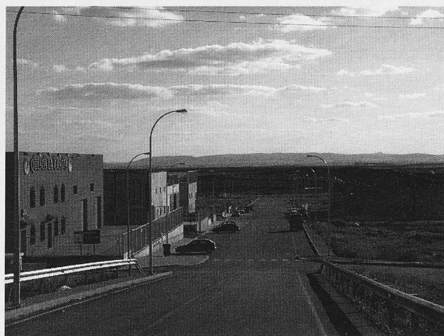
Imagen reciente del polígono industrial.
