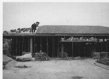
Finalización obras aula educación especial
