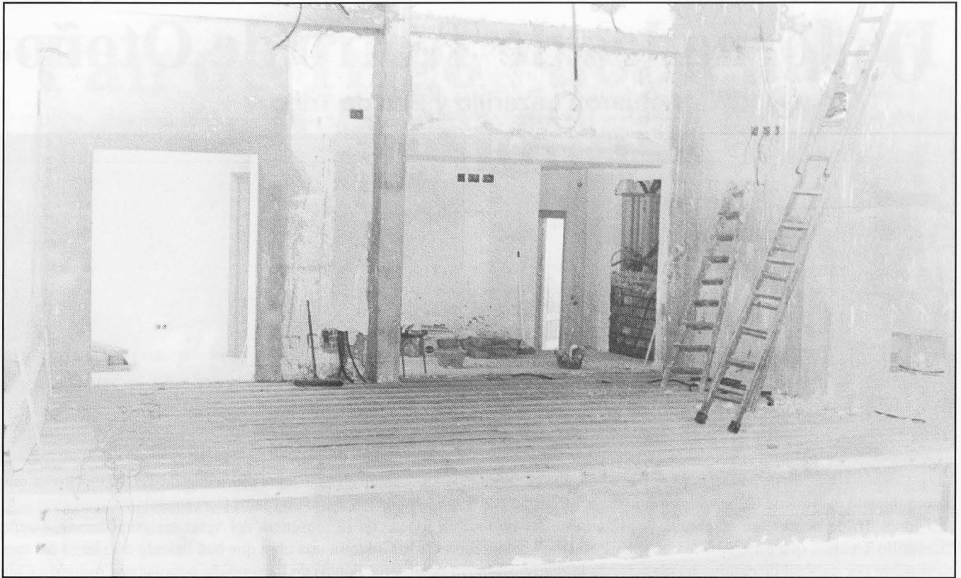
Imagen del escenario en obras.
