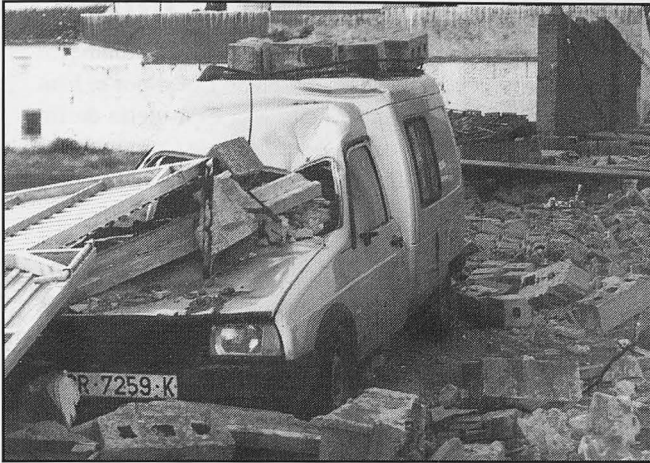
Un muro cayó sobre este coche que circulaba por la calle.
