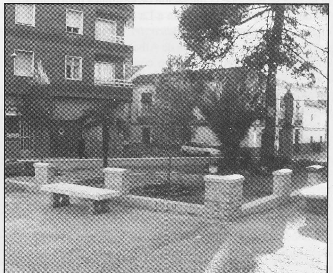
El jardinillo del Cristo del Amor presenta este aspecto desde que se están acometiendo las obras de acondicionamiento.
