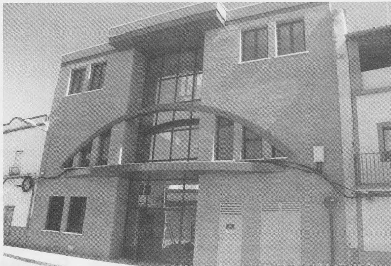
Fachada de entrada al edificio.
