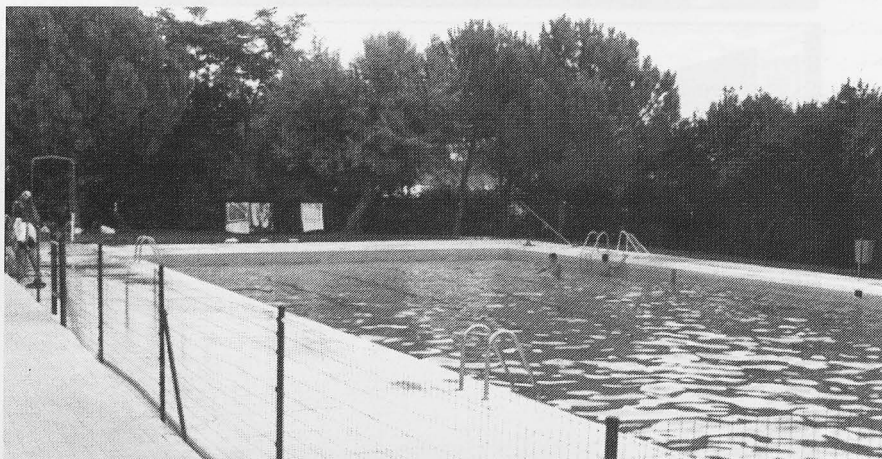
Esta será el vaso de la piscina a climatizar.
