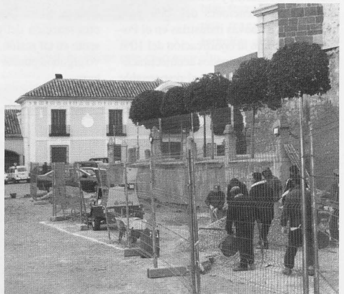
Imagen de las recién iniciadas obras.
