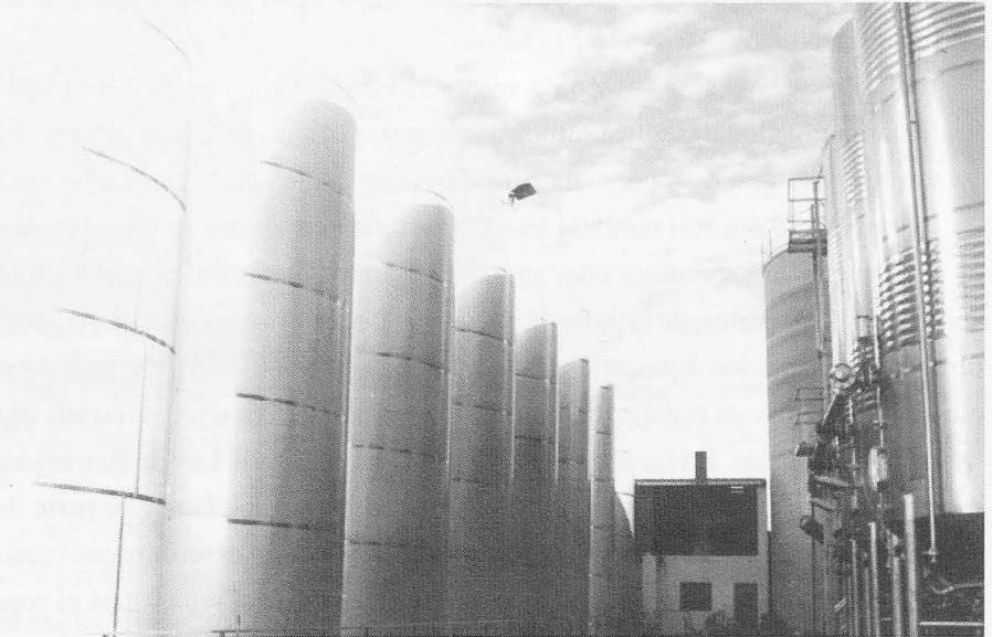
Nuevos depósitos instalados donde se asentaba la antigua bodega.
