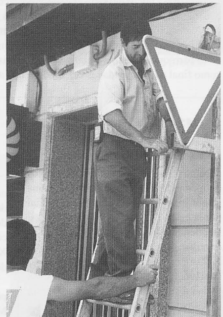
Operarios municipales colocando una señal de "Ceda el paso".
