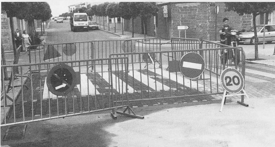
También se han construido nuevos pasos de cebra elevados.
