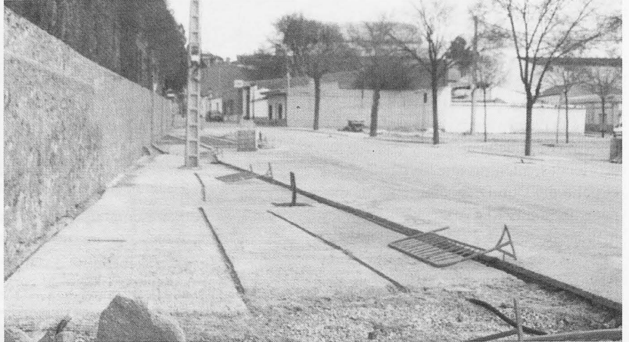
Estado de las obras en el nuevo bulevar.
