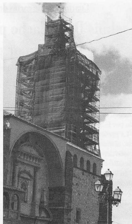
Obras de restauración de la iglesia.
