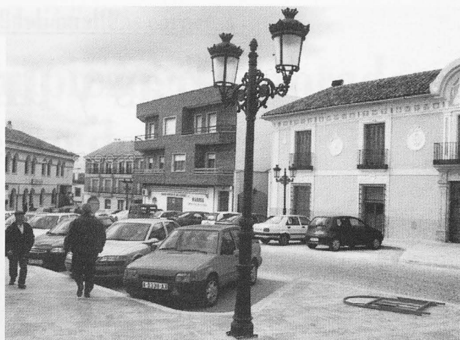
Obras de la Plaza Don Diego.
