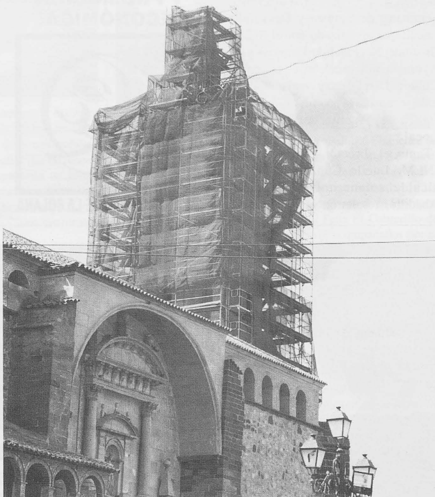
La torre en plena restauración.
