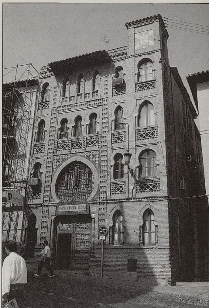
La venta del edificio de Fedeto de la Cuesta del Alcázar ha acarreado muchos problemas. Por fin, a finales del año se concretaba la venta a Repalsa.
