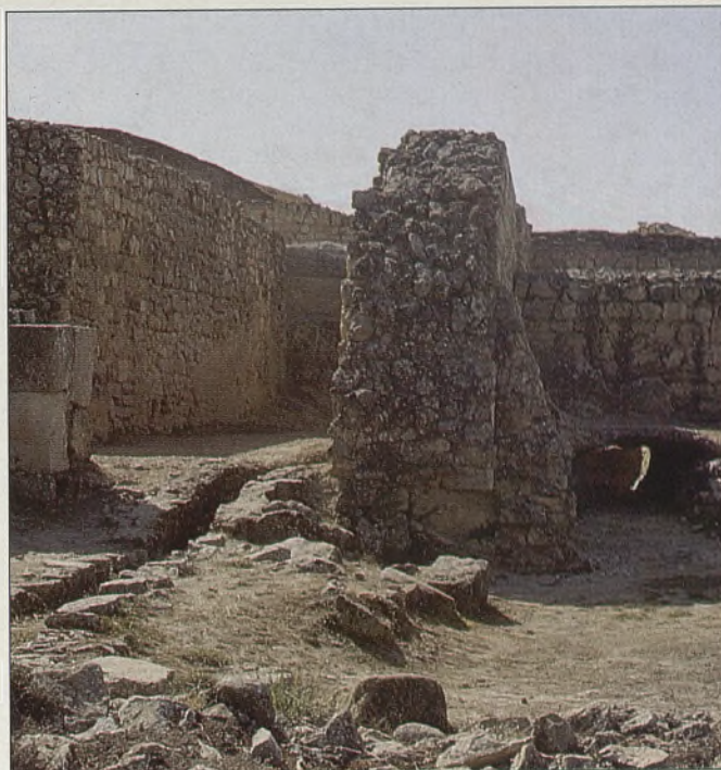
Las termas formaban parte de la red de abastecimiento urbano de agua potable.
