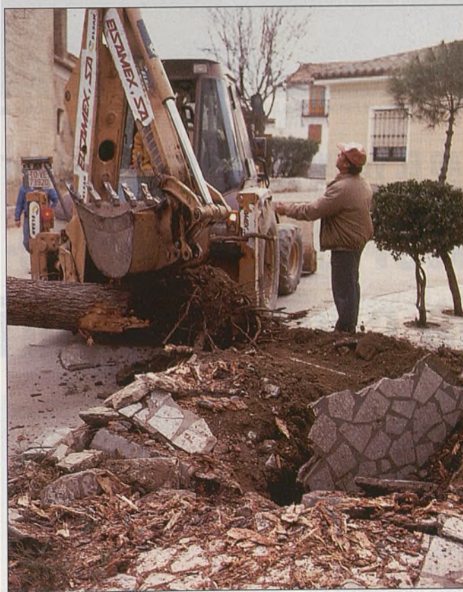
En la foto se puede ver que las raíces del pino no eran tan grandes como para levantar la acera
