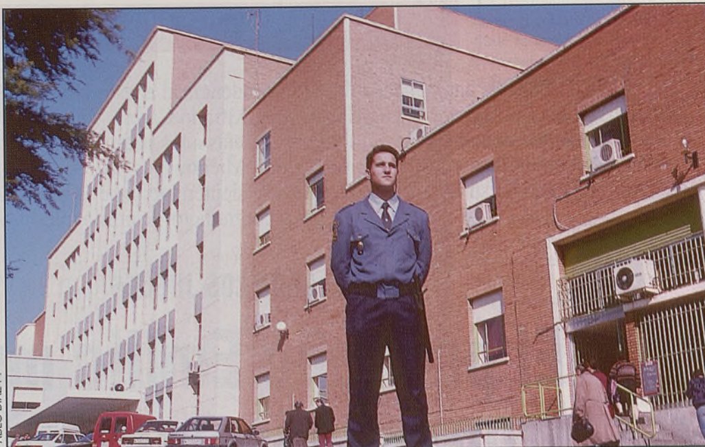
El hospital Alarcos de Ciudad Real.
