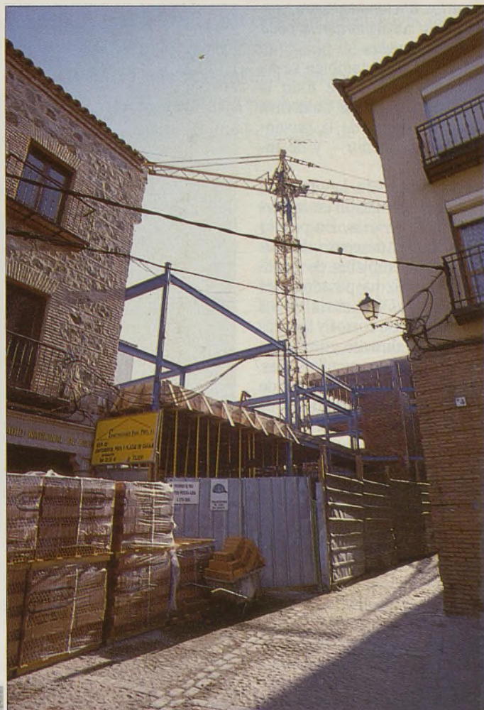
En el paseo de San Cristóbal sólo había permiso para demoler una de las dos casas originales.
