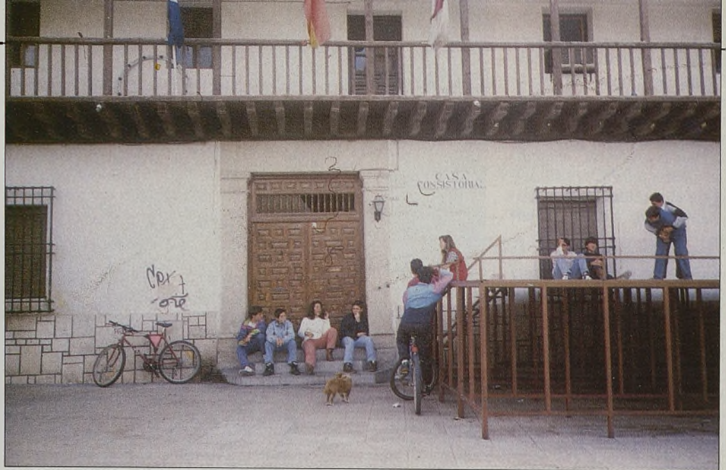
El Ayuntamiento de Almonacid, de arquitectura popular, se encuentra registrado en el inventario arquitectónico de España. Se caracteriza por tener un corredor de madera a lo largo de toda la fachada principal.
