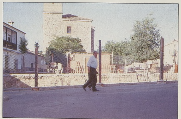
En la foto, lo que queda de lo que fue el antiguo Ayuntamiento de Almonacid, que será levantado de nuevo.
