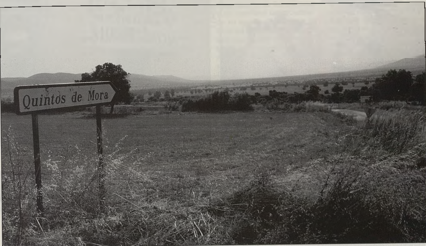
Las obras han durado diez años y para ello se perforó un monte de roca dura en la finca de Los Quintos.
