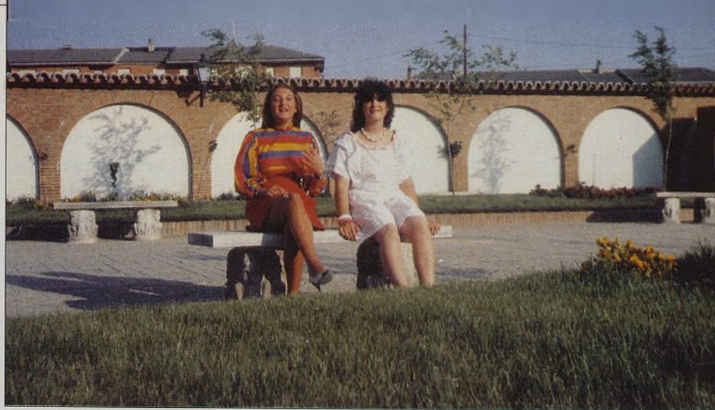
Ascensión, la joven fallecida, y su amiga Inma, herida en el accidente, en un banco del parque. Detrás se puede ver el muro que se derrumbó sobre ellas.
