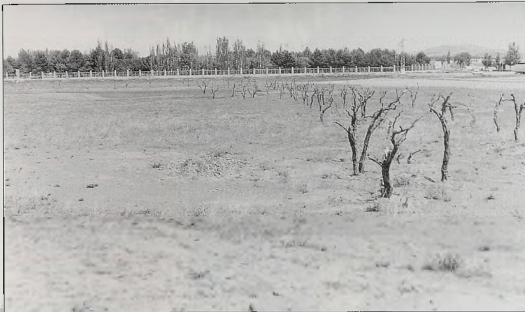
Después del movimiento de tierra las obras del campo de golf se paralizaron.
