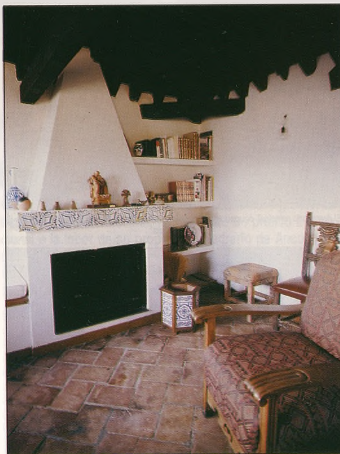
Rincón del torreón donde se hizo la chimenea aprovechando el tiro existente, a los lados se construyó una leñera-sofá y una librería de albañilería.
