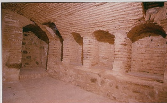
En el sótano, que se utilizaba como cuadra, se conservan hasta los pesebres.
