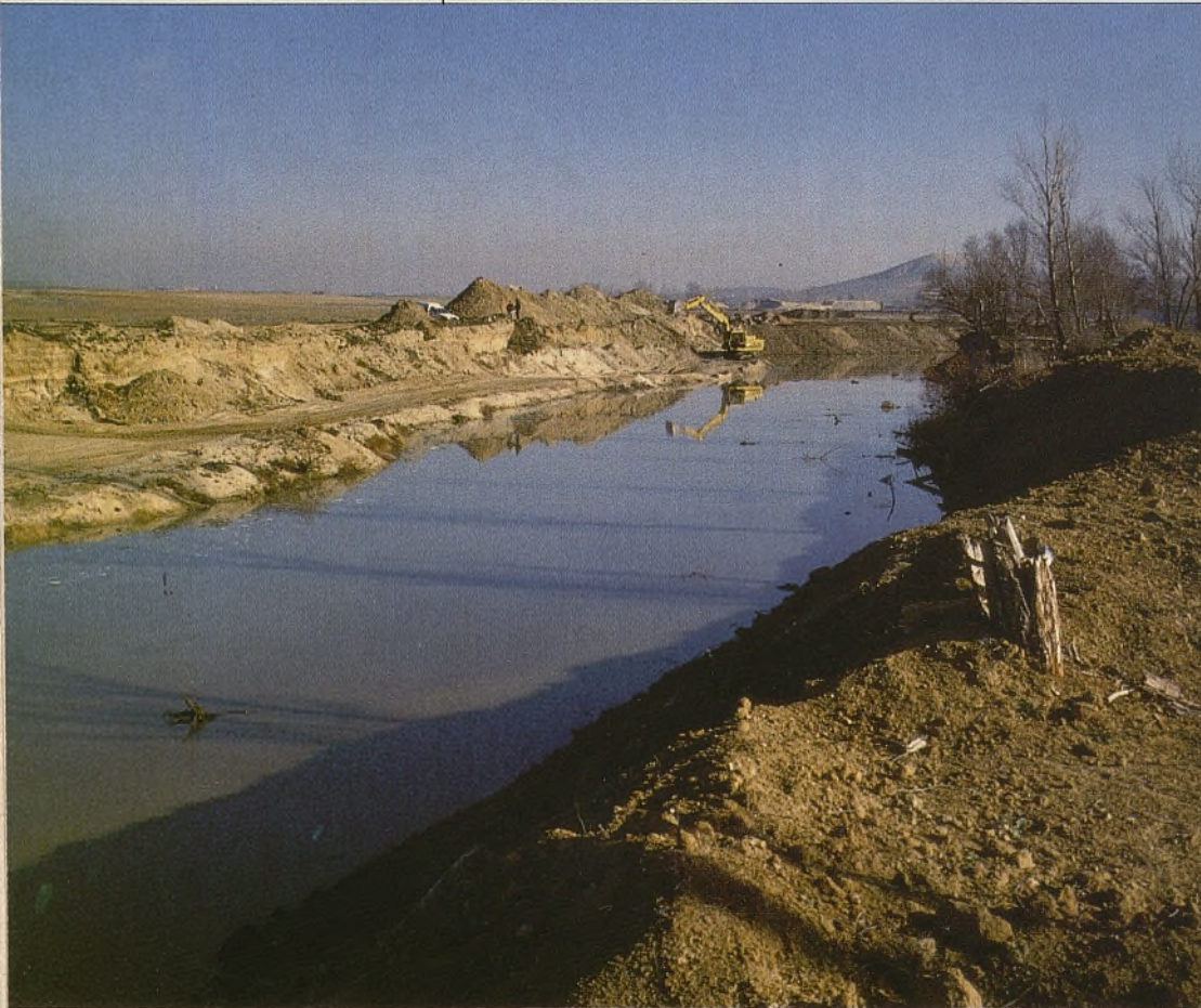
La arbolada de la orilla ha sido arrancada de cuajo y no se ha replantado nada, a pesar de la exigencia municipal.
