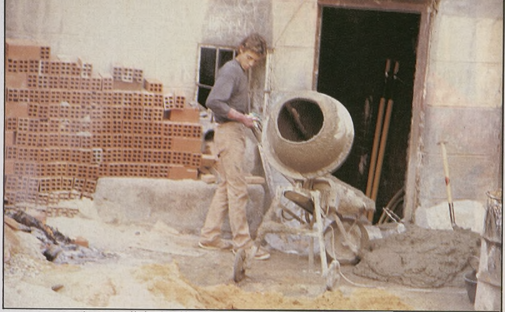
La construcción ha absorbido mano de obra de otros sectores, principalmente del agrícola.
