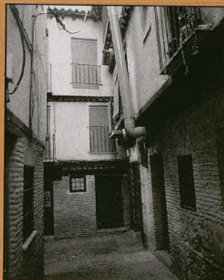
En el barrio de la judería toledana y en el callejón de Bodegonas, un tubo extractor de humos atraviesa toda la fachada.
