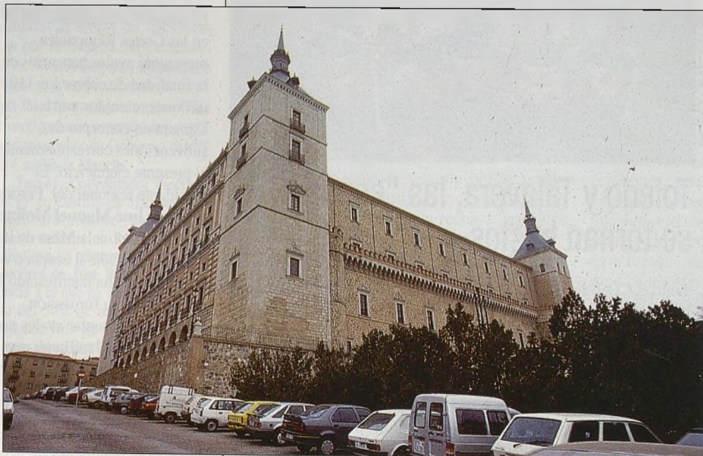
El próximo mes de febrero comenzarán las obras en la planta principal del Alcázar para dar cabida a los fondos antiguos de la Biblioteca
