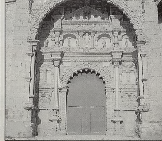
Fachada de la colegiata de Torrijos.
