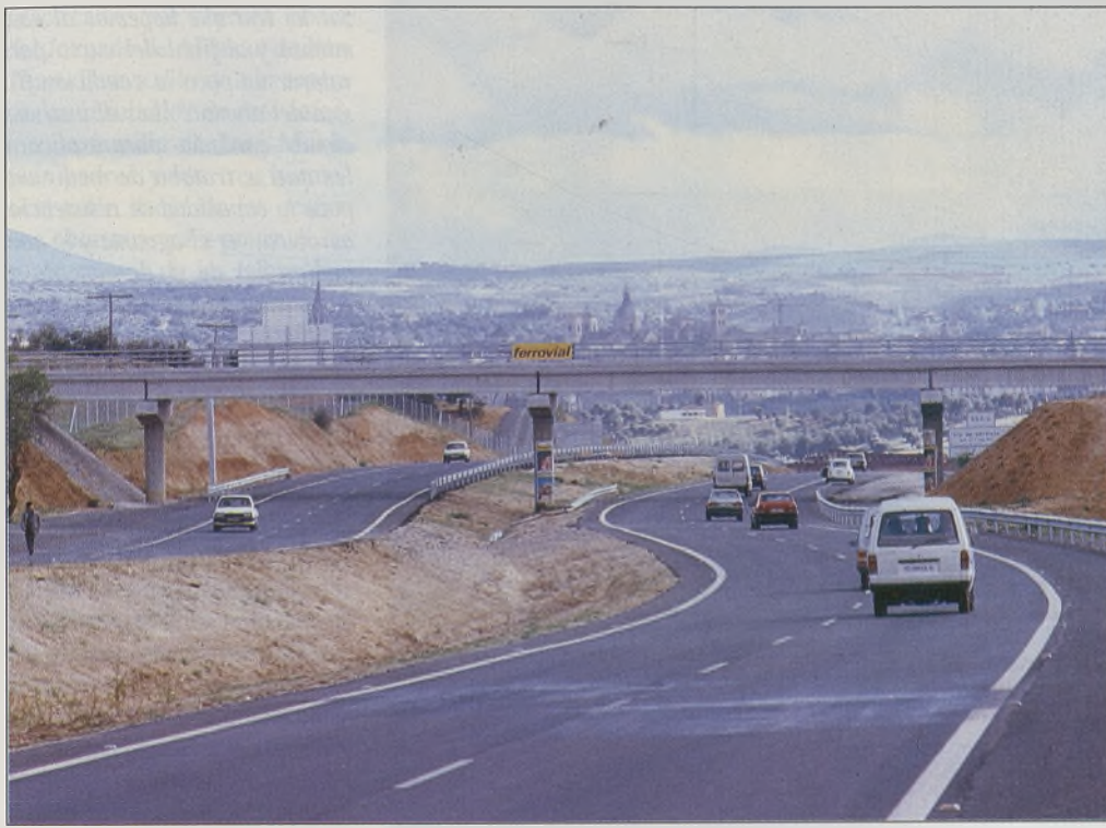
Los defectos de construcción hacen que la autovía se vuelva muy peligrosa con la lluvia, según todas los conductores consultados
