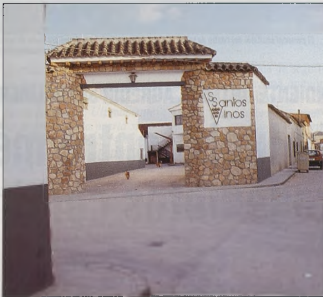
La bodega de Sabiniano Santos está inactiva.
