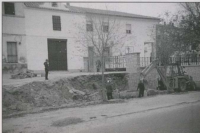
OBRAS EN EL ARROYO DEL CRISTO DE MORA. Las obras de canalización del arroyo del Cristo de Mora ya han comenzado. Se trata de lograr que el cauce de este río discorra normalmente y evitar que se desborde cuando las lluvias sean fuertes. Las obras comprenden además la sustitución del antiguo puente por uno nuevo, así como el ajardinamiento en la zona de la residencia de ancianos.
