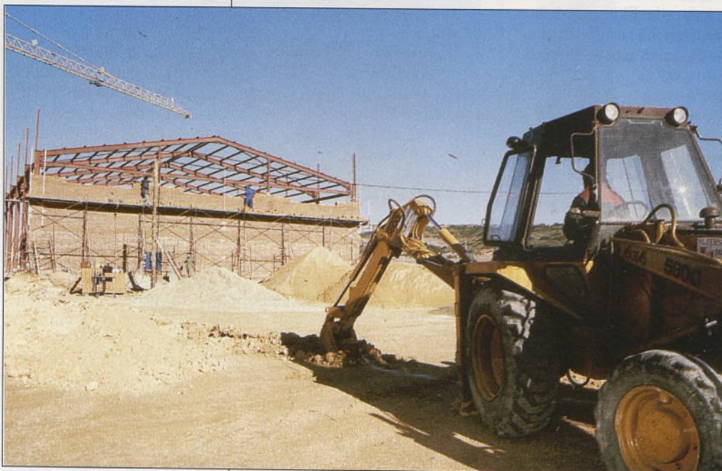
El Parque de Bomberos de Villacañas, actualmente en construcción, deberá entrar en funcionamiento a finales de este año.
