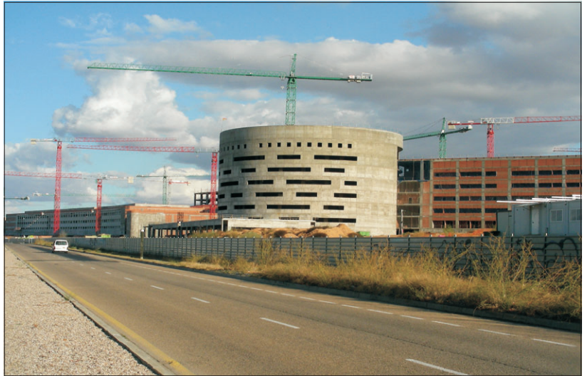
Obras abandonadas desde hace tres años en Avda. Guadiana (antes Boladiez).
