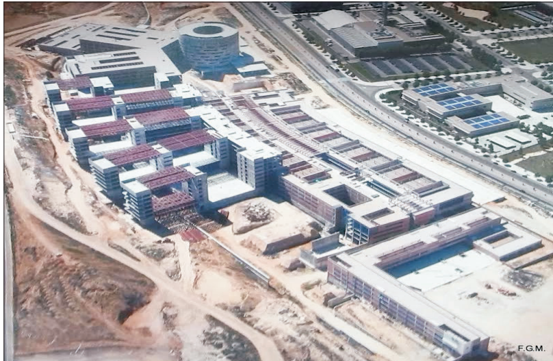
Vista general de la actual situación de toda la edificación.
