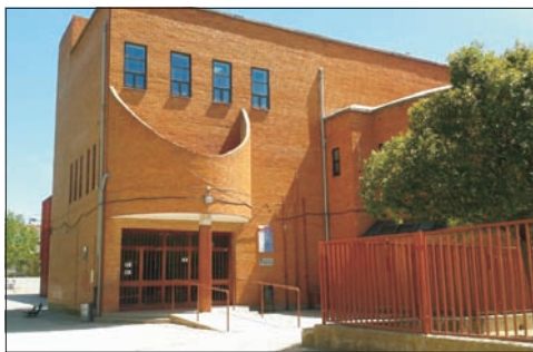
El Foxá necesita mantenimiento y renovación.
