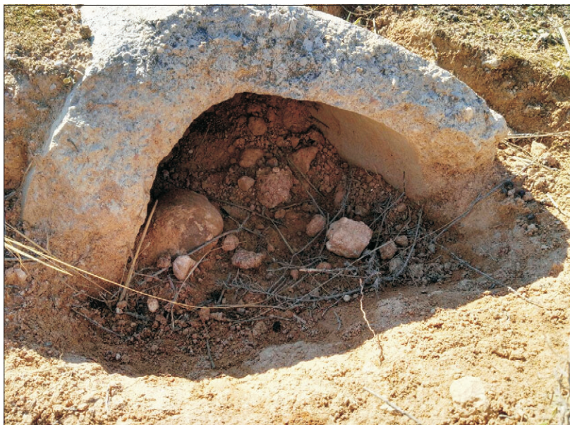
Restos de amianto descubiertos en el parque situado entre Laguna de Arcas y Río Badiel.
