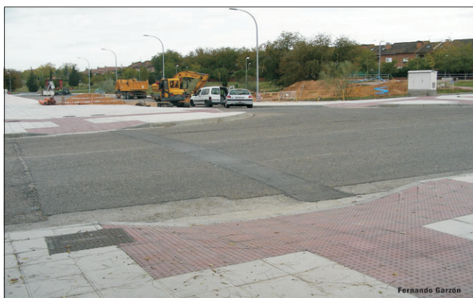
Paseo de Manuel Machado sobre Valdeyernos sin pintar.
