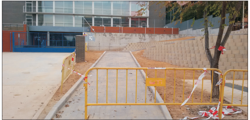
La rampa entrará en funcionamiento en los próximos días.
