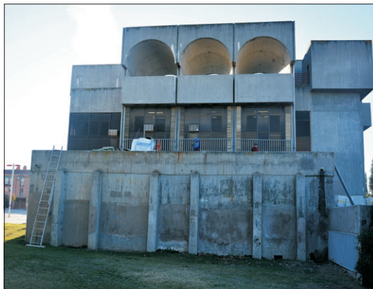
Obras en la Biblioteca.
