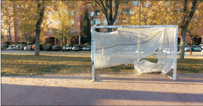
Detrás de la portería había una malla protectora que desapareció, es necesario reponerla.
