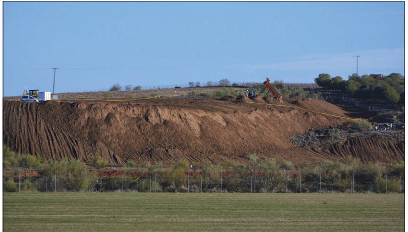
TRAGSA es la encargada de «tapar» el amianto.
