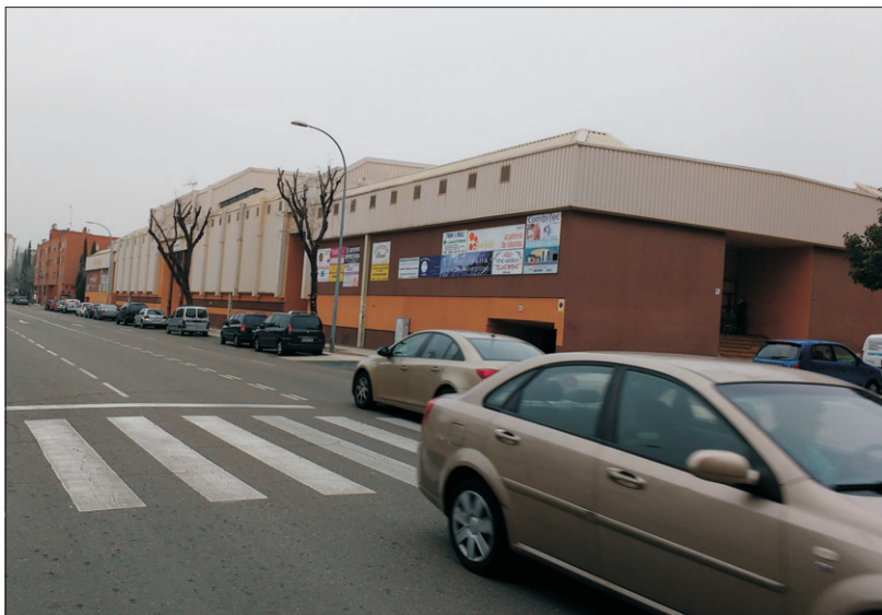
Hay que reforzar las medidas en paso de peatones problemáticos como este.
