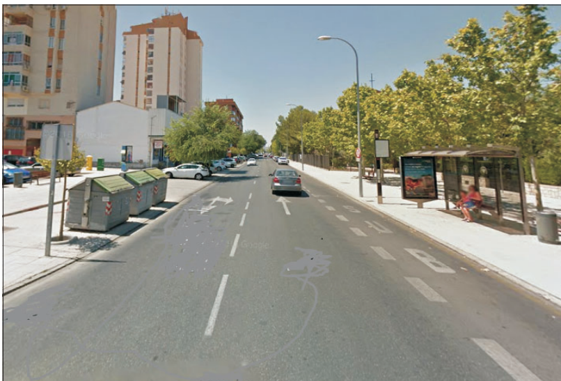
La parada de autobús en la parte izquierda debe reordenarse así como estudiar un nuevo paso de peatones en la intersección Cascajoso con Alberche.
