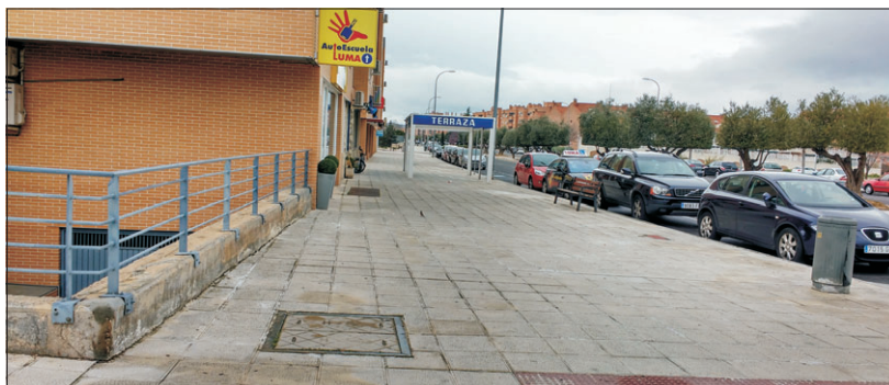
Acerado en Boladiez sin árboles, duro de transitar en verano.
