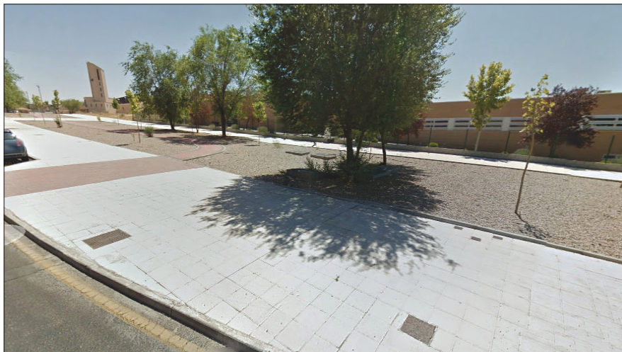
Esta zona de la calle Bullaque entre Boladiez y Fresnedoso está sin instalación de iluminación.
