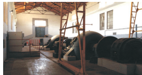
Central hidroeléctrica Valteina (Valladolid)
