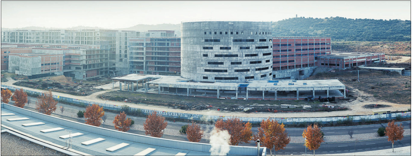
Panorámica general del actual estado del hospital. Foto: Pedro Salvador.
