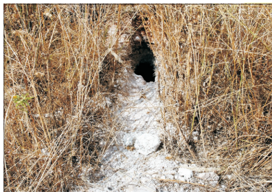
Madrigueras de amianto. - Los conejos se mueven a sus anchas entre los tubos de fibrocemento y encuentran refugio en los propios lodos, donde escavan sus madrigueras. Forman parte de la cadena trófica y se encuentran en una zona de caza.
