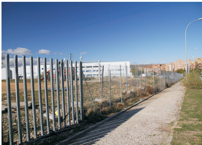
El acerado y los parterres de la calle Estenilla están sin hacer.
