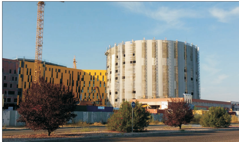
Las obras del hospital avanzan a buen ritmo.
