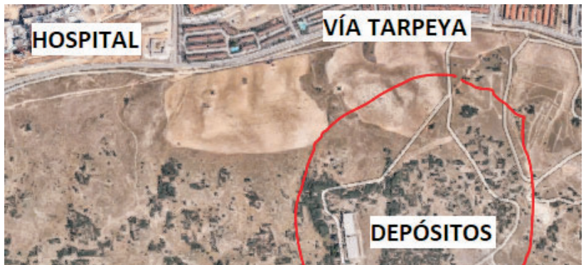
Junta y Ayuntamiento están desamiantando en Laguna de Arcas y en la zona de los depósitos.
