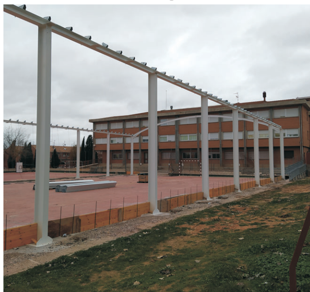
Obras del colegio Gómez Manrique.
