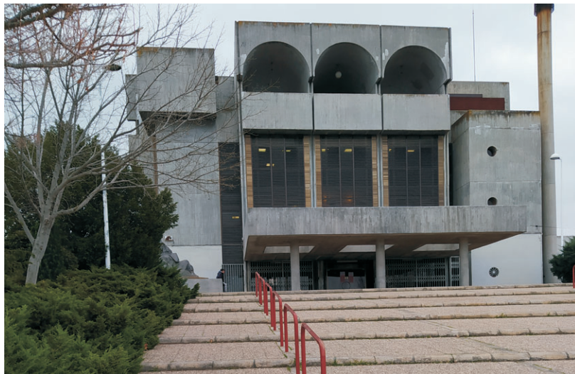
El Ayuntamiento afronta una remodelación amplia de la biblioteca del barrio.
