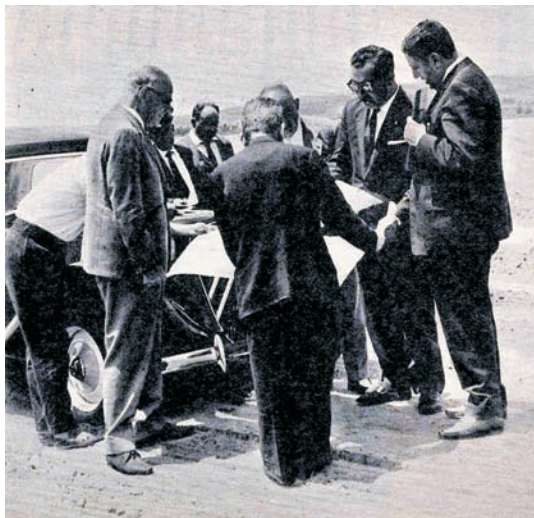
Tecnócratas de la autarquía trazando en obra el Polígono de Santa María de Benquerencia.
