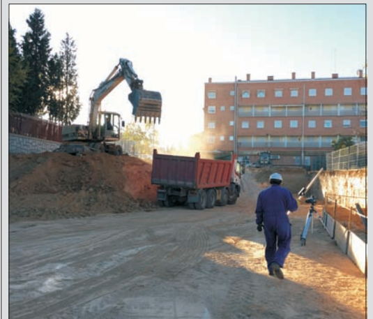
Obras del complejo Vitápolis.
