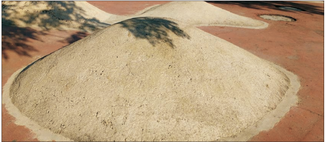
Se quitó el recubrimiento de esponja y dejaron el hormigón que puede provocar arañazos a los niños.
