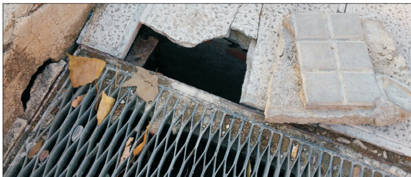
Rotura en arqueta que presenta peligro, denunciado hace más de un mes y medio.
