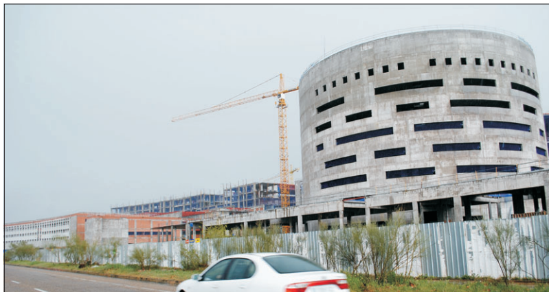
Entre otras obras la avenida Río Guadiana deberá contar con dos amplias rotondas.
