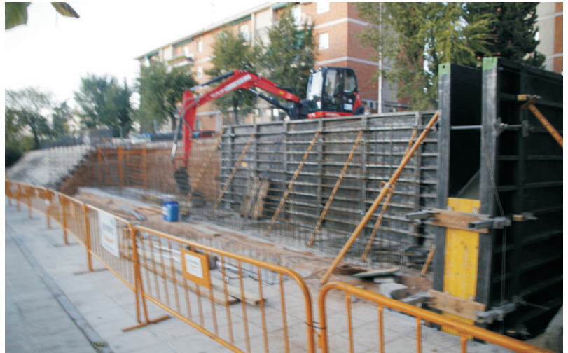
Obras para la rampa de Tiétar.
