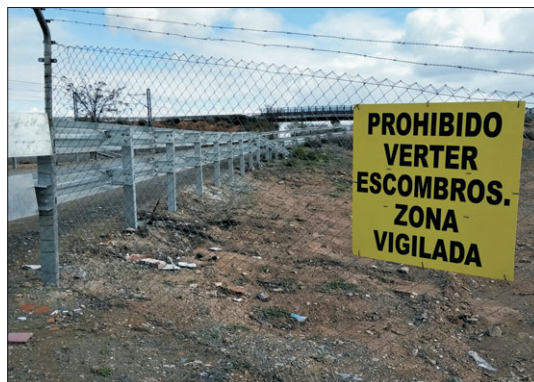
Prohibido tirar escombros junto a la vía del AVE.
