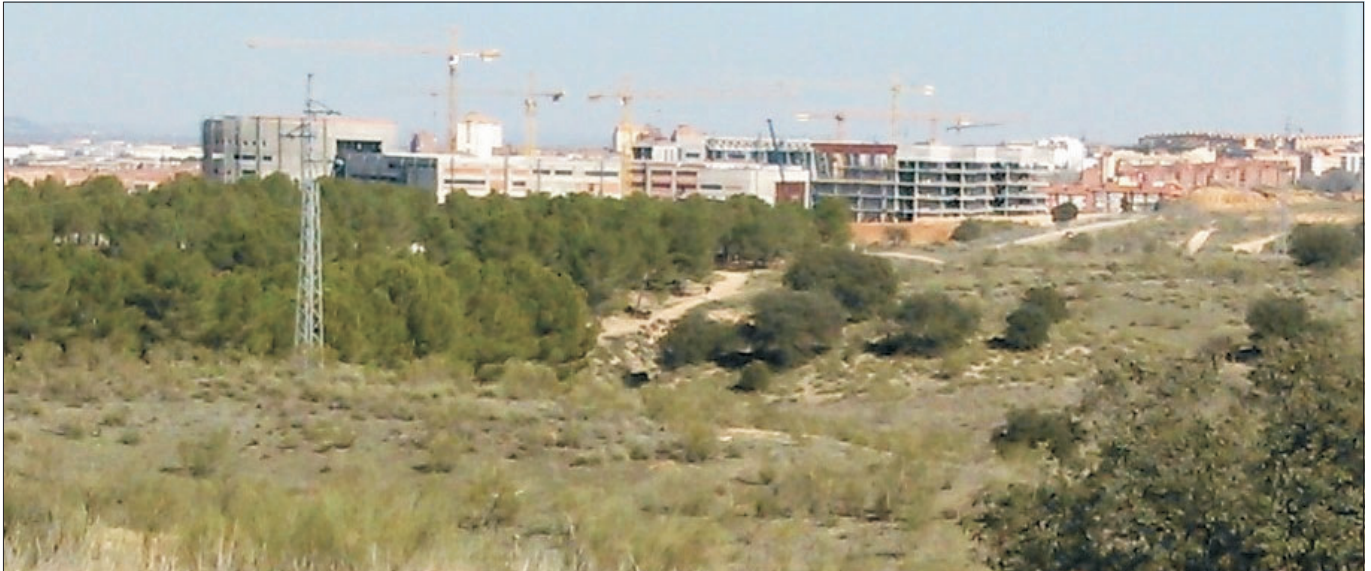
Zona por la que discurrirá la vía entre el hospital y la cuesta de las Nieves.
