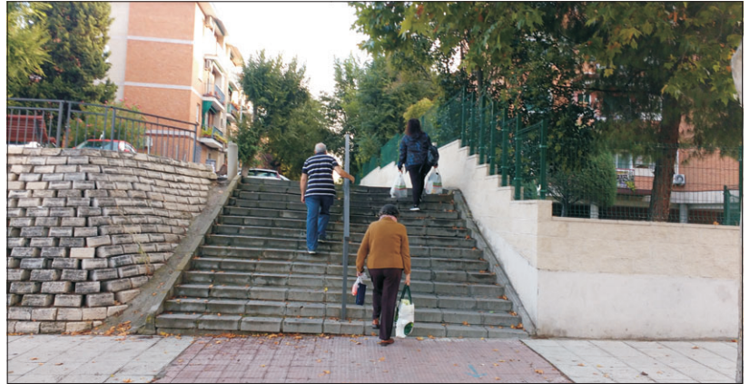
La realización de una rampa en este lugar espera habiendo sido la propuesta más votada en la ciudad.
