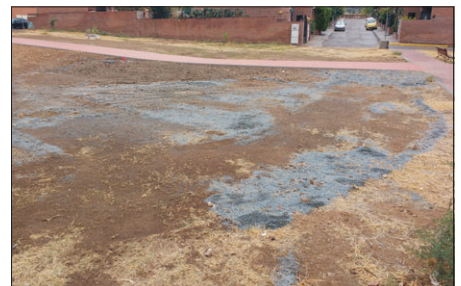
Vertido de hormigón de la obra.
