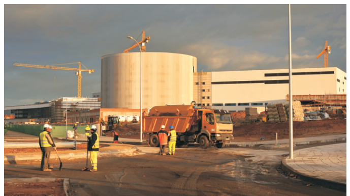
Rotonda en Río Guadiana terminando el asfaltado. Foto: José L. González
