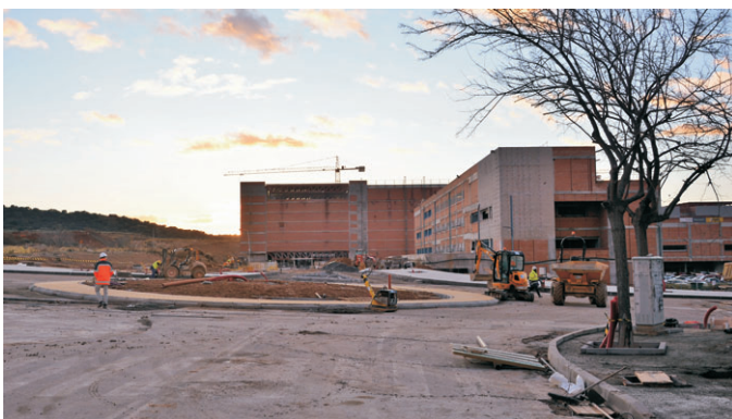
Rotonda de entrada al hospital vista desde Fresnedoso. Foto: José L. González
