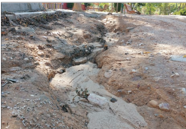
El Paseo central del parque queda en este estado cada vez que llueve.
