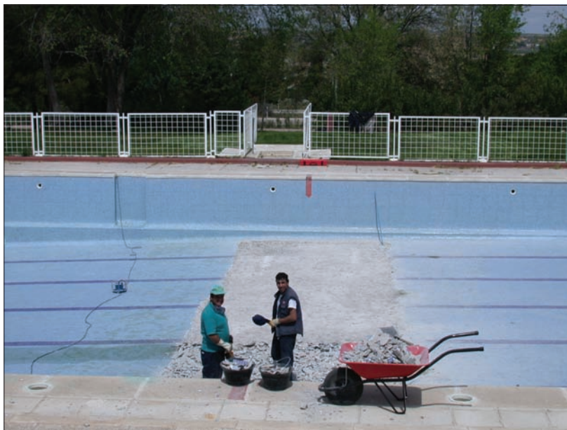
Una de las restauraciones que ha tenido la piscina.
