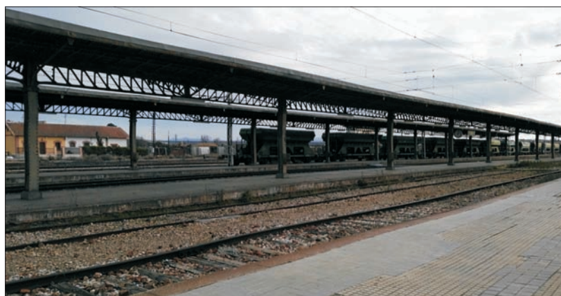
Andenes en la estación de Algodor fuera de servicio.
