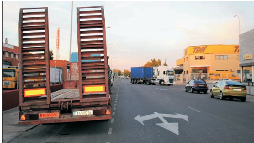
La calle Río Jarama arteria principal del Polígono industrial necesita una gran renovación.
