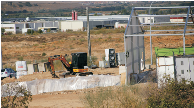
Siguen los trabajos de retirada de amianto en Laguna de Arca.
