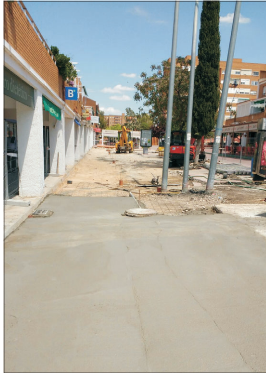
Demolición y hormigonado del primer tramo del paseo.
