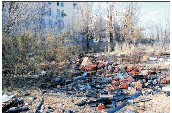
Escombrera en la calle Laguna de Arcas.
