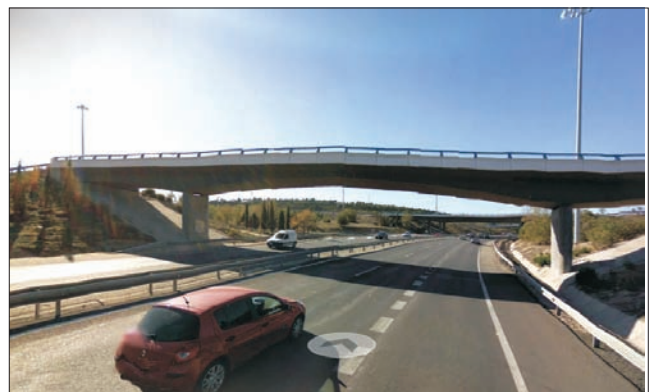
Los puentes de la autovía sobre la N-400 están siendo reparados.
