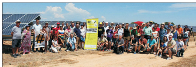
Planta solar fotovoltaica socializada por la cooperativa SomEnergía, en Torija, Guadalajara.
