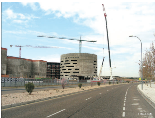
Obras del hospital desde la calle Guadiana.
